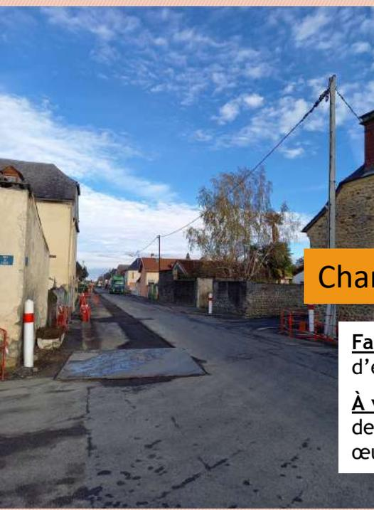
**Fait** : mise en souterrain des réseaux électriques, téléphoniques et d'éclairage public ; remplacement de la conduite d'eau potable.
